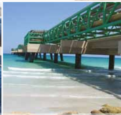
Jetty Pile Protection
