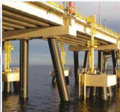
Jetty Pile Protection
